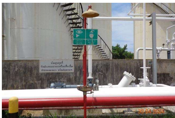
รูปที่ 2-32 ที่อาบน้ำและล้างตาในกรณีฉุกเฉิน
