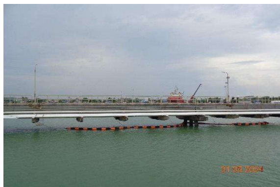
รูปที่ 2-11 ที่กั้นเพื่อป้องกันการแพร่กระจายน้ำมันในกรณีเกิดการรั่วไหลลงทะเล
