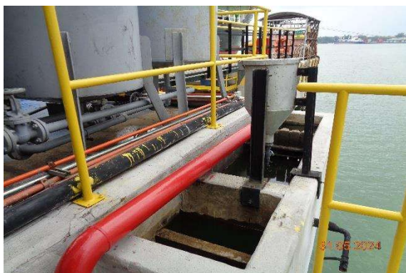
รูปที่ 2-9 บ่อ API และคันกันเพื่อตักน้ำมันและภาชนะรองรับน้ำมัน บนท่าเทียบเรือ
