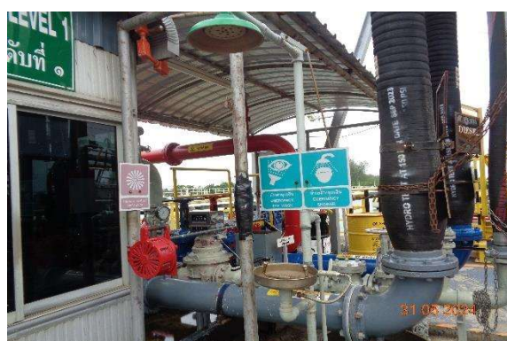
รูปที่ 2-20 จุดอาบน้ำและล้างตา กรณีฉุกเฉินบนท่าเทียบเรือ
