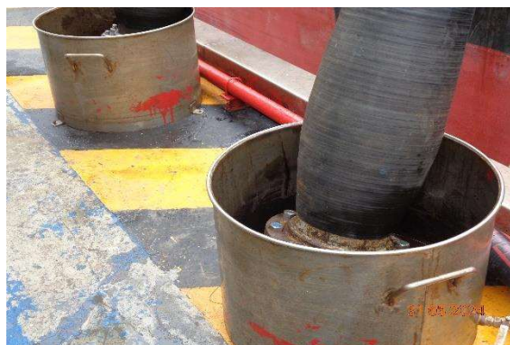
รูปที่ 2-9 บ่อ API และคันกันเพื่อตักน้ำมันและภาชนะรองรับน้ำมัน บนท่าเทียบเรือ
