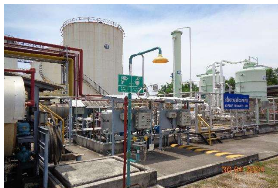
รูปที่ 2-32 ที่อาบน้ำและล้างตาในกรณีฉุกเฉิน
