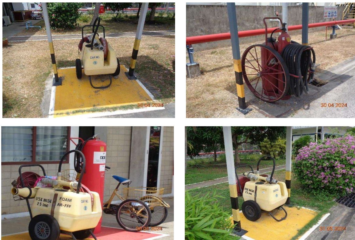
รูปที่ 2-17 รถฉุกเฉินซึ่งมีอุปกรณ์ด้านการป้องกันอัคคีภัยและเหตุการณ์รั่วไหลของน้ำมัน
