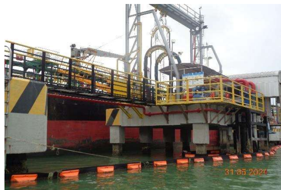
รูปที่ 2-11 ที่กั้นเพื่อป้องกันการแพร่กระจายน้ำมันในกรณีเกิดการรั่วไหลลงทะเล
