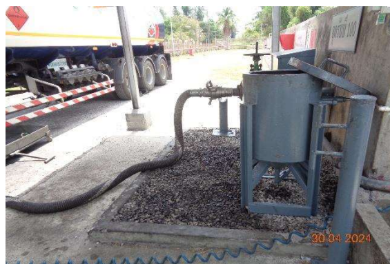
รูปที่ 2-34 บริเวณจุดจ่ายน้ำมันที่รองรับน้ำมันเปื้อน น้ำมัน หรือน้ำมันที่อาจหกรั่วไหลได้
