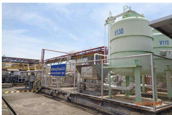
รูปที่ 2-30 เครื่องควบคุมไอระเหย่น้ำมัน
