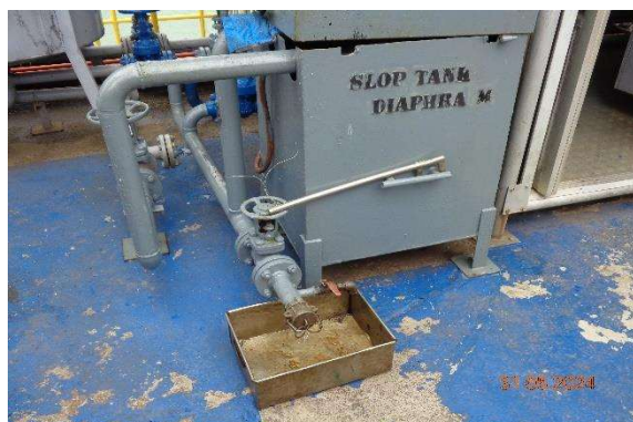
รูปที่ 2-10 ภาพขณะรองรับน้ำมัน และถังบรรจุซีเมนต์เพื่อซับน้ำมัน
